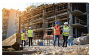
工事現場の監視と 進捗記録
